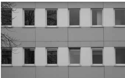
Obstoječa stavba pred prenovno
