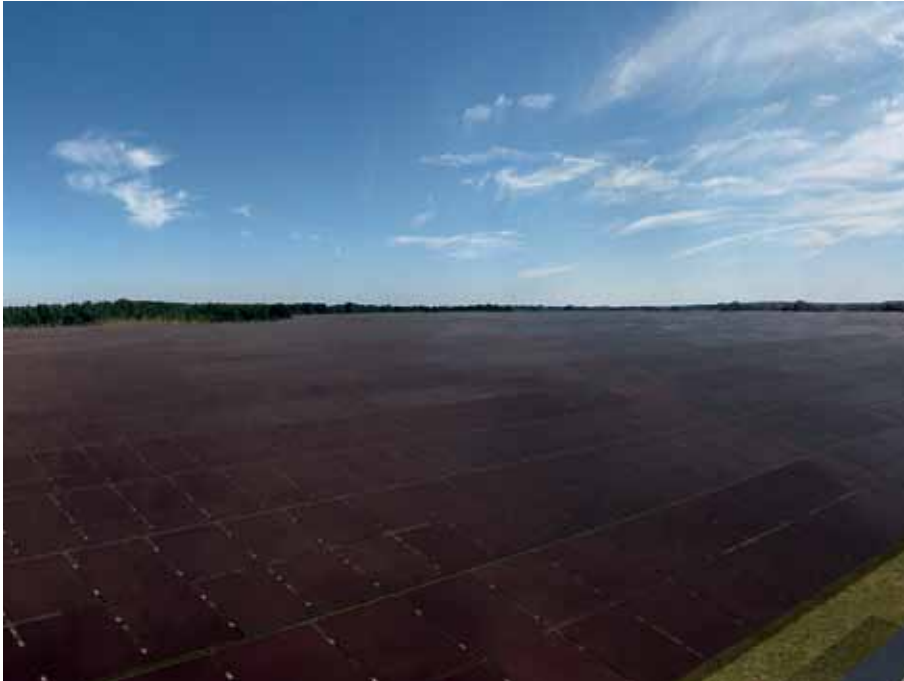
Schüco MSE 100 na prosti zunanji površini s Schüco tankoslojnimi moduli MPE iz serije aSi natur Schüco MSE 100 ground-mounted system with Schüco MPE thin-film modules in the aSi natural series
