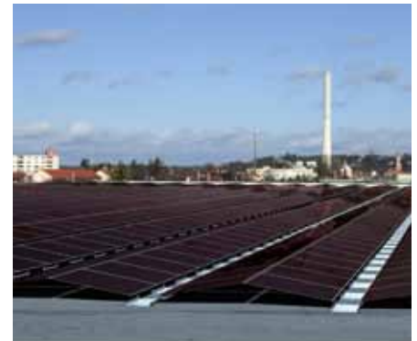
Schüco MSE 100 elektrarna na ravni strehi vzhod/zahod Schüco MSE 100 flat-roof mounting east/west
