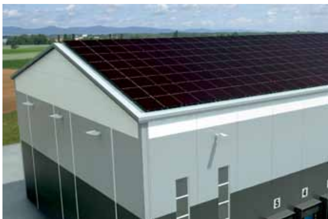
Montaža 15° poševne strehe na skladiščni hali 15° pitched roof installation on a warehouse
