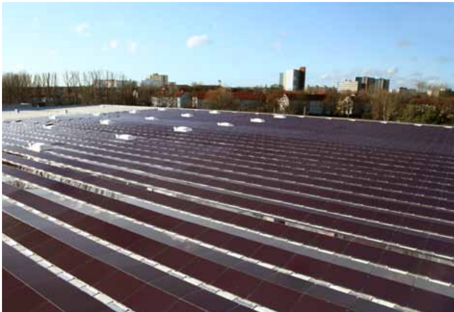
Schüco MSE 100 elektrarna na ravni strehi vzhod/zahod Schüco MSE 100 flat-roof mounting east/west
