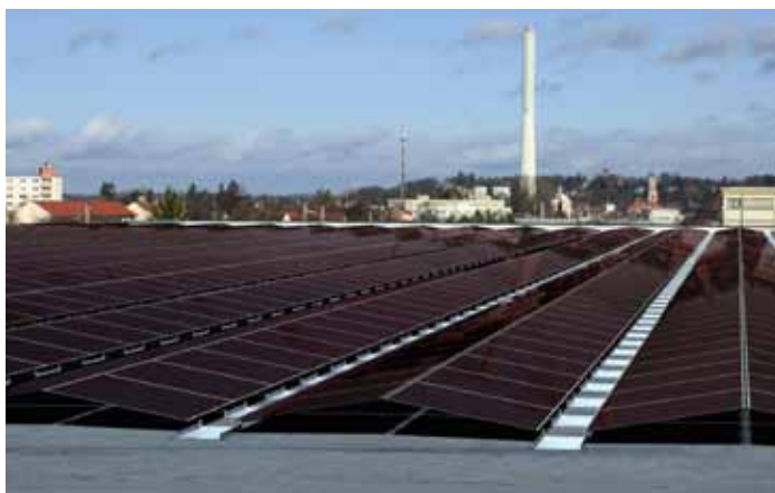
Schüco MSE 100 montaža na ravne strehe vzhod/zahod Schüco MSE 100 flat-roof mounting east/west
